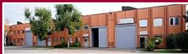
BONCATO S.r.l. BSP1 Steel Point 1 di Arese (MI)
